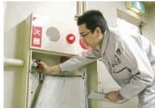
消防用設備などの点検
