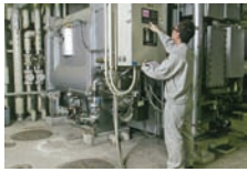
冷暖房・空調関係の点検と整備
