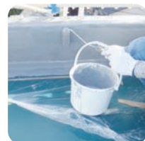
屋上屋根 防水工事
