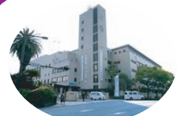
県庁舎電気設備 保守管理派遣業務委託
