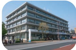
長崎市役所及び上下水道局庁舎等
